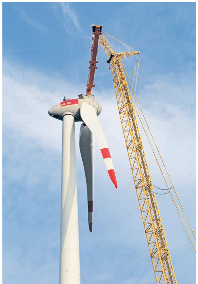
Montage einer Enercon E-115 in Lengerich
